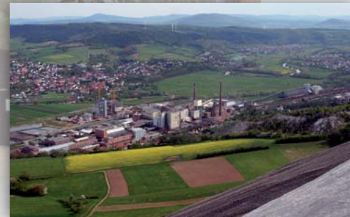
Standort Wintershall des Werkes Werra. Im Bau die Abfallverbrennungsanlage der E.ON
