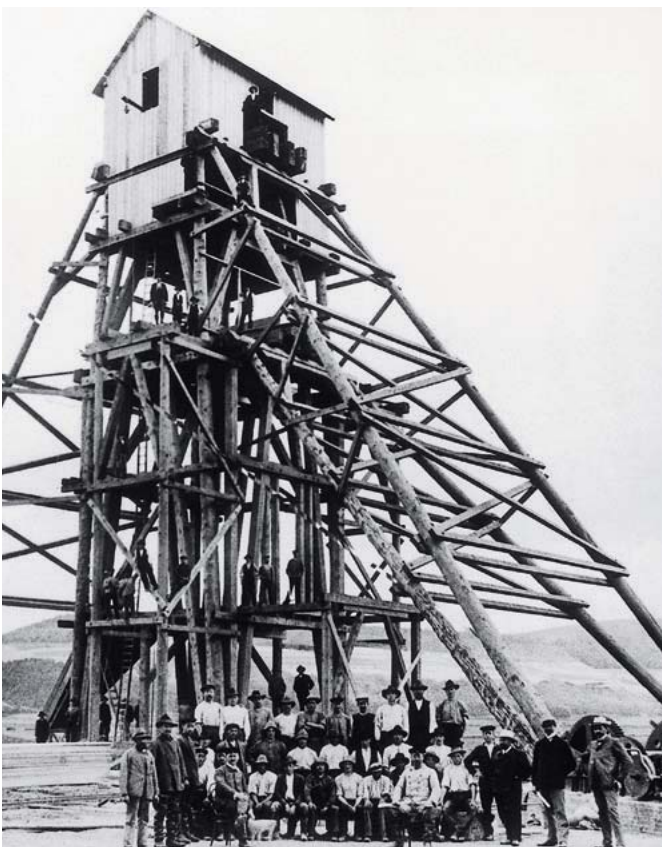
Bild 4: Teufen des Schachtes „Heringen“ des Werkes Wintershall (ca. 1909).
