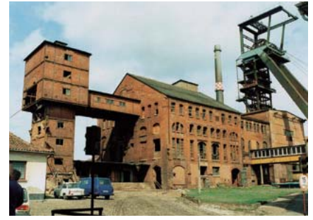
Bild 10: Kaliwerk „Volkenroda“ in Thüringen 1991 (nach Stilllegung)
