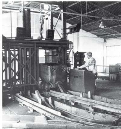
**Bild 13: Grube Falkenstein, Wagenumlauf auf der Hängebank**
