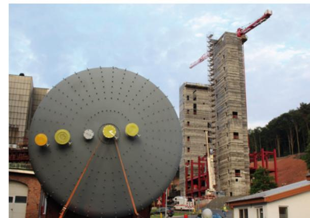
Bild 4: Ausrührgefäß beim Antransport von Fa. Messer zur Baustelle
