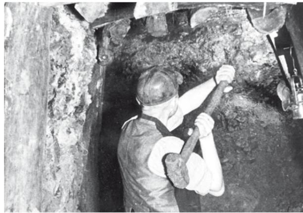
Bild 7: Grube Auguststollen, Abbau mit Getriebezimmerung
