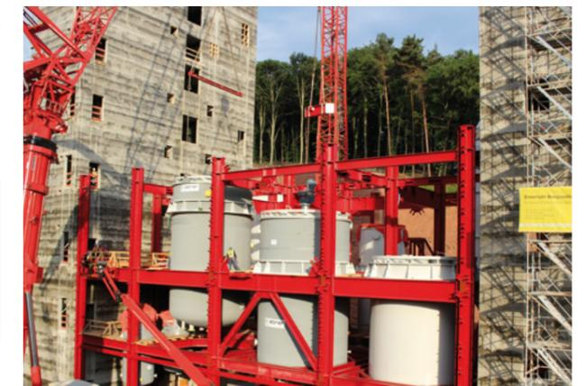
Bild 5: Die ersten Großbehälter sind in der untersten Etage in den Stahlbau eingesetzt
