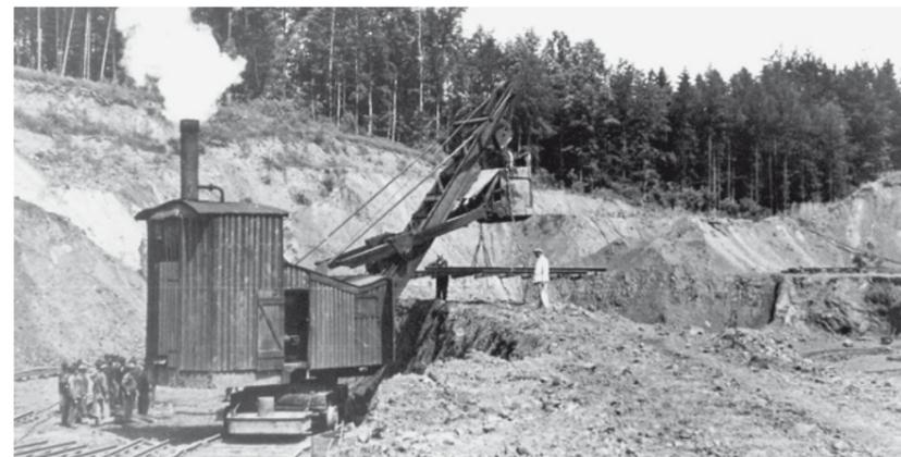
Bild 8: Grube Auguststollen, Tagebau mit Dampfbagger, 1950
