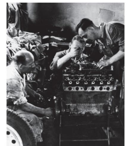
Bild 9: Montage eines Flugmotors in Abteroda über Tage
