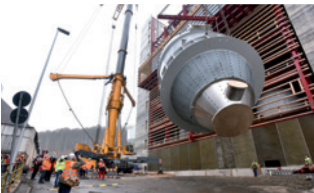
Einhub des größten Apparates, eines Verdampfers, in den Rohbau der KKF-Anlage
