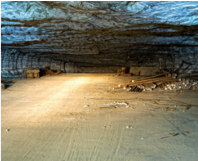
Bild 3: Betonierter Fertigungsraum (später Lagerraum des Kaliwerks)
