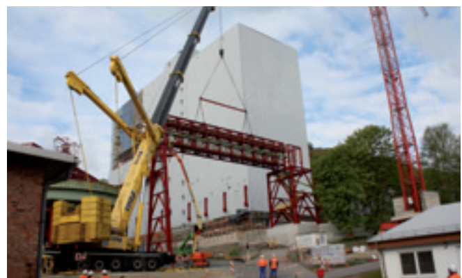
Montage der Rohrleitungen zwischen KKF-Anlage und Fabrikbetrieb Hattorf
