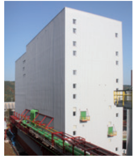
Rückwärtige Ansicht der neuen KKF-Anlage
