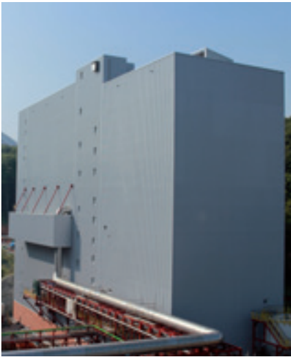
Die fertig gestellte KKF-Anlage
