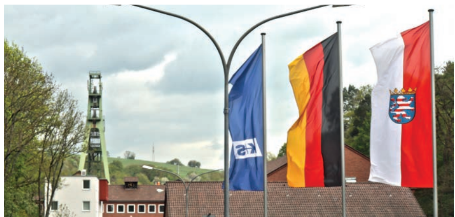
Abb. 5: Die Schachtanlage Hera der Grube Hattorf-Wintershall (Philippsthal) mit Werkstor und Fördergerüst im Hintergrund
