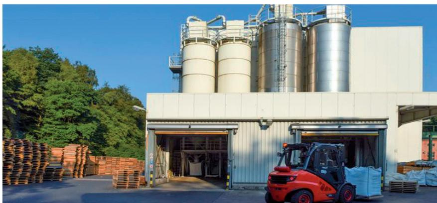
Abb. 17: Siloanlage für das Abfüllen von Filterstäuben in big bags
