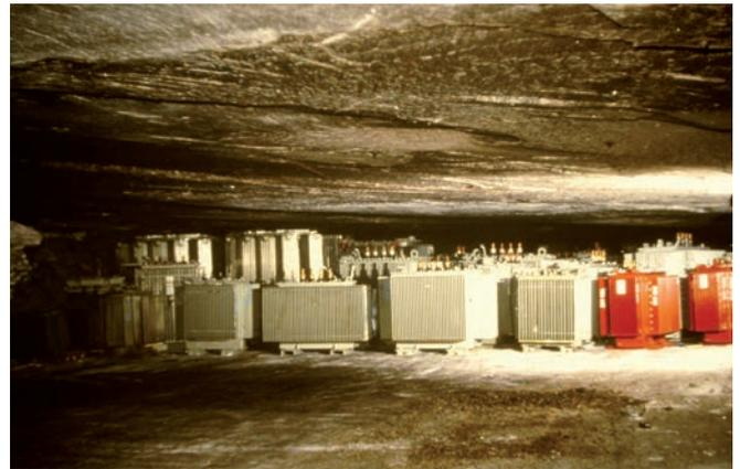
Abb. 7: Einlagerungsraum für PCB-haltige Transformatoren
