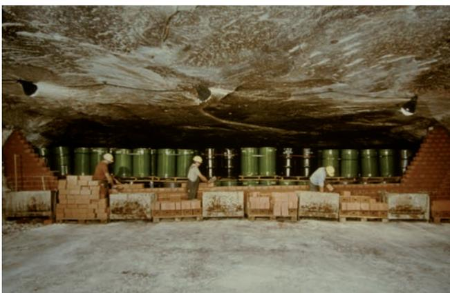
Abb. 9: Maurer bei der Errichtung einer Abschlussmauer eines Ablagerungsraumes
