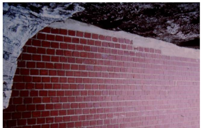
Abb. 10: Fertige Abschlussmauer eines gefüllten Ablagerungsraumes
