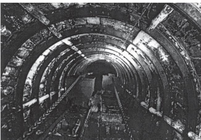
Bild 8: Förderung der Braunkohle Borken: Kettenbahn im Tiefbau Altenburg
