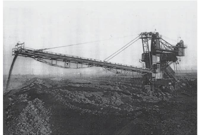
Bild 11: Borken: Tagebauverkippung mit Absetzer
