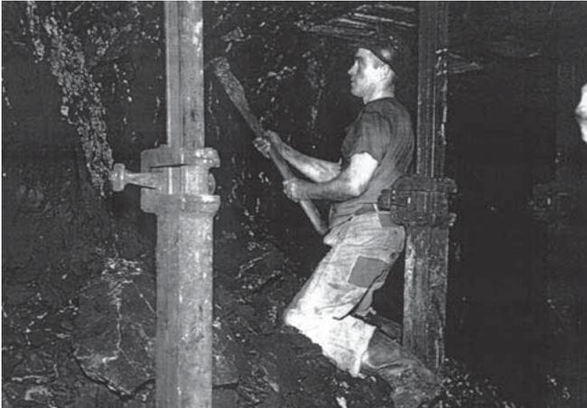
**Bild 12: Braunkohlegewinnung im Streifenbruchbau mit Eisenstempeln**
