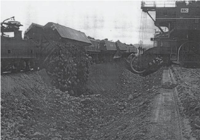
Bild 10: Borken: Tagebauverkippung mit Absetzer, hier Entladen der Abraumwagen
